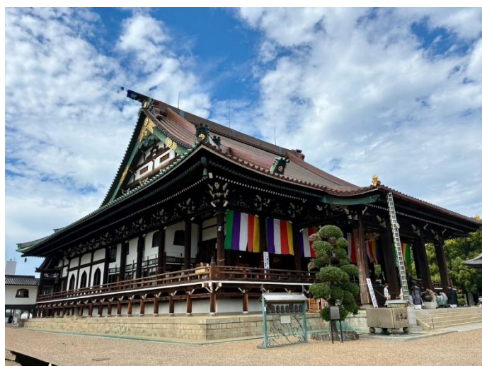
改修なった大念仏寺の本堂 ～府下最大級の木造建造物～
