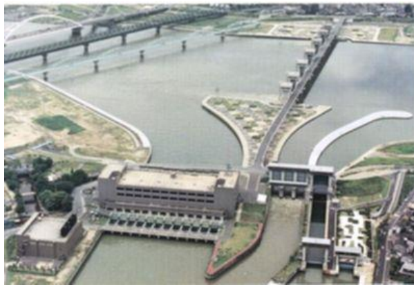
← 淀川 毛馬 大堰、排水機場、水門、閘門
